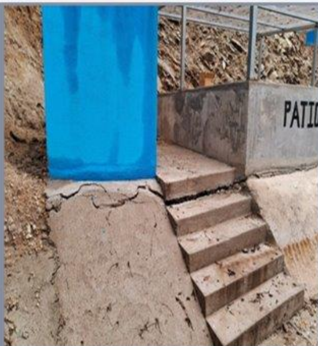
Vista de la calidad constructiva de la obra, cercana a la caseta que contiene el equipo de cloración.
