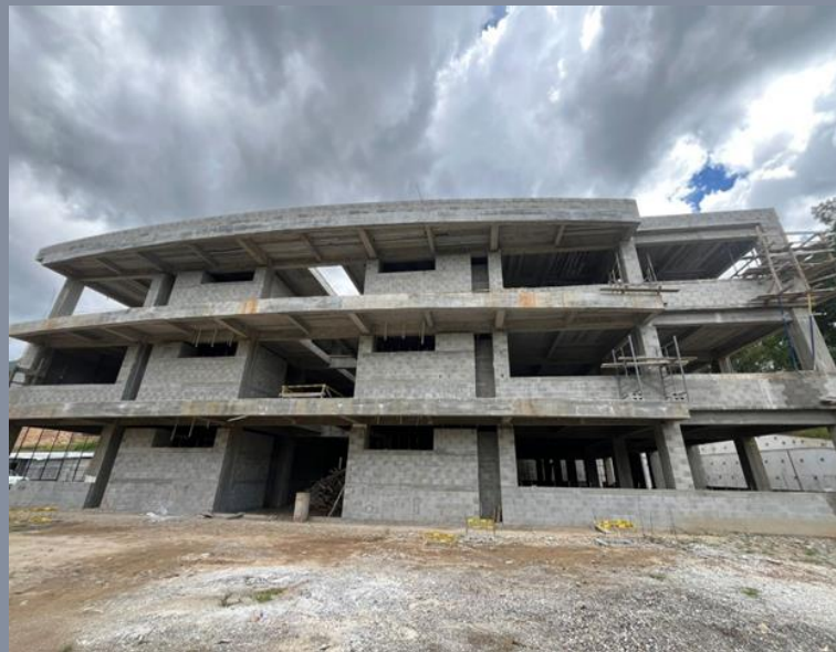
Vista exterior del proyecto.
