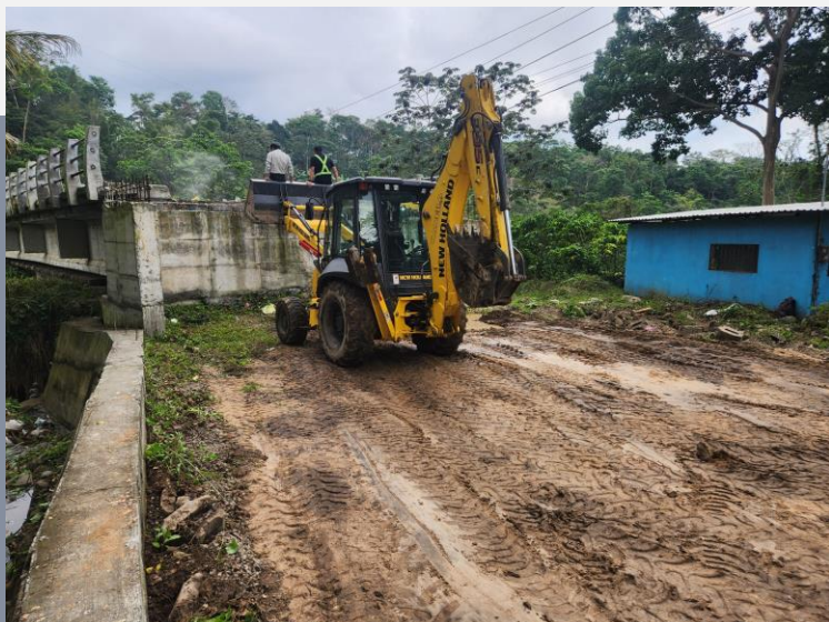
Maquinaria trabajando rampas de acceso al puente.
