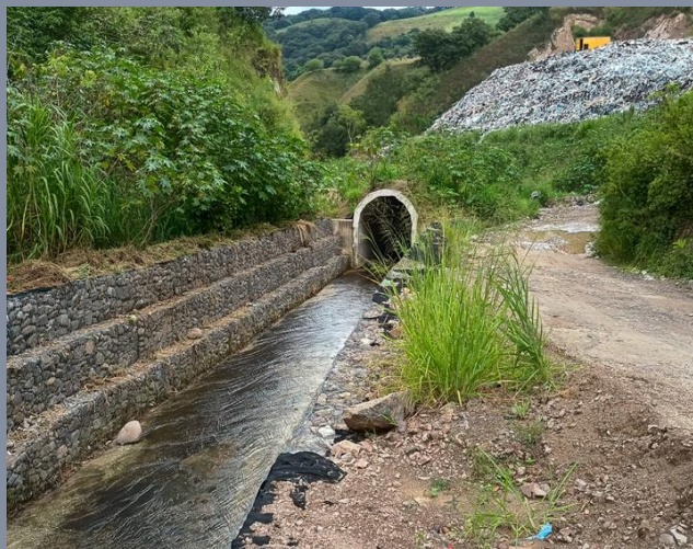
Vista de las obras de infraestructura para protección de los recursos hídricos
