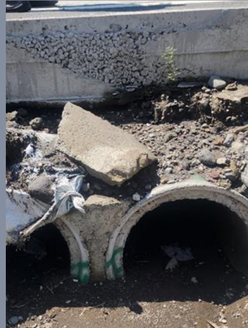
Vista del quintel que existía en el tramo a ejecutar.
