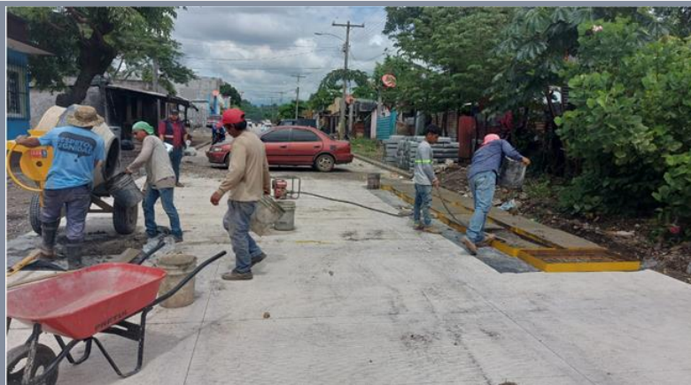
Pavimentación de calle
