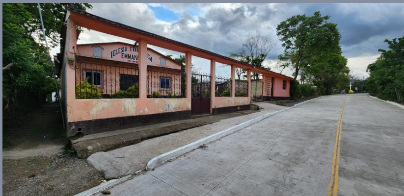
Vista de la iglesia de la comunidad que se encuentra en la periferia del pavimento mejorado.
