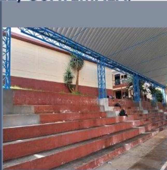
Vista lateral de la cancha y el techo curvo con sus columnas de soporte.
