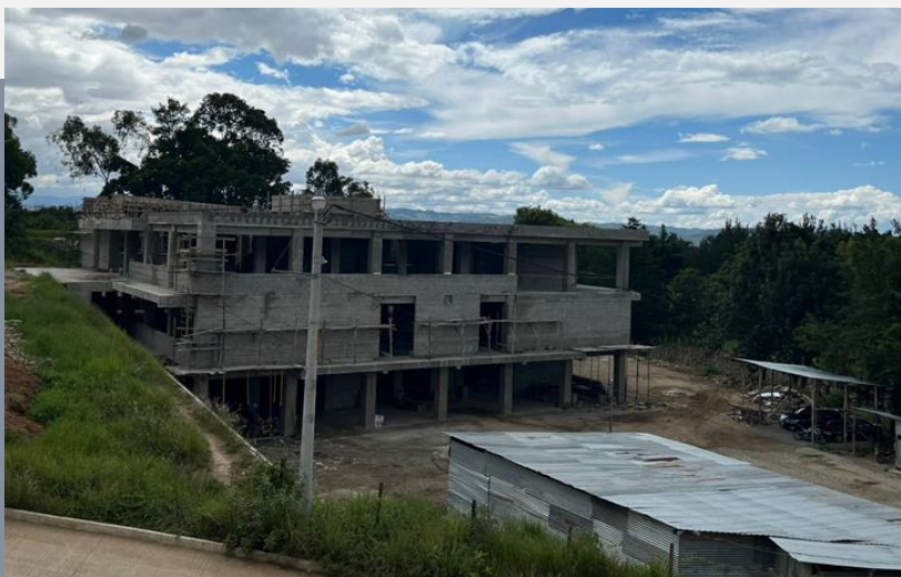
Vista exterior del proyecto.
