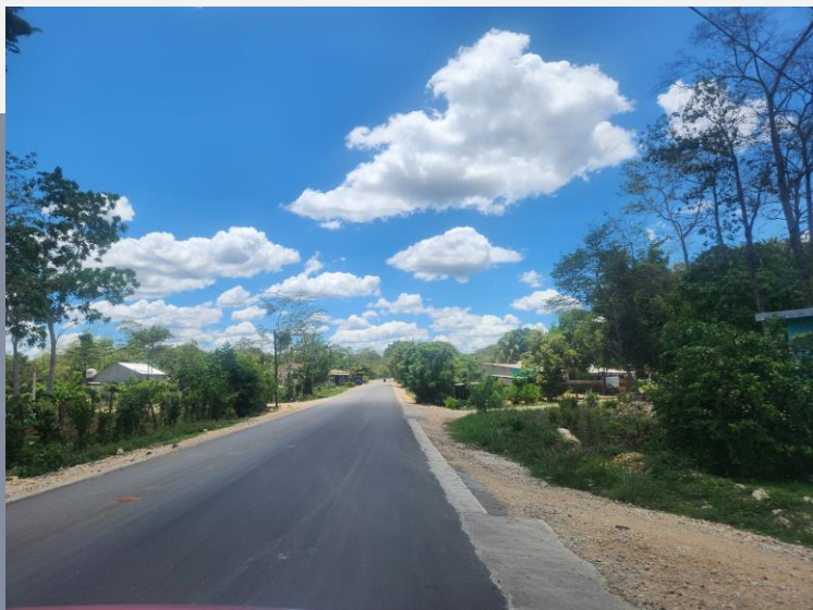
Tramo mejorado con concreto asfaltico.
