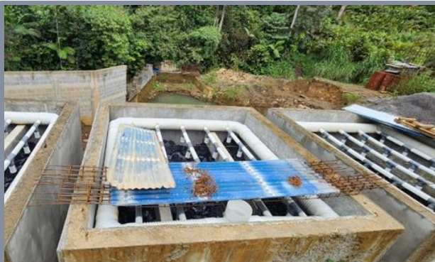
Construcción filtros percoladores
