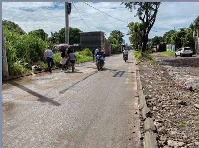
Pavimentación en dos de los cuatro carriles existentes
