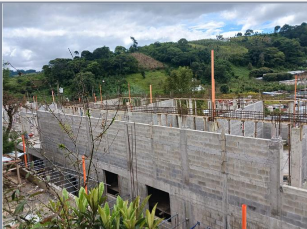
Vista módulo de aulas de dos niveles.
