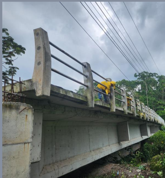
Personal pintando puente
