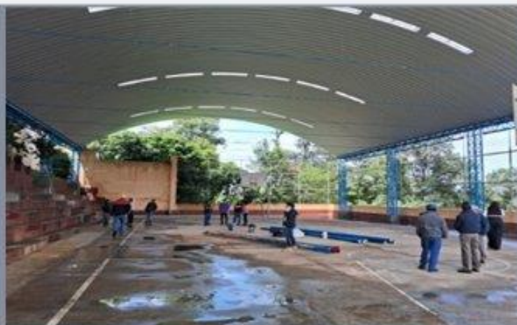
Vista general del techo curvo instalado.
