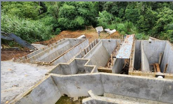
Vista construcción caja distribuidora, tanques Imhoff y desarenador
