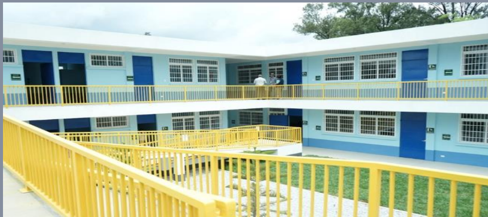
Vista general de rampa de la escuela.
