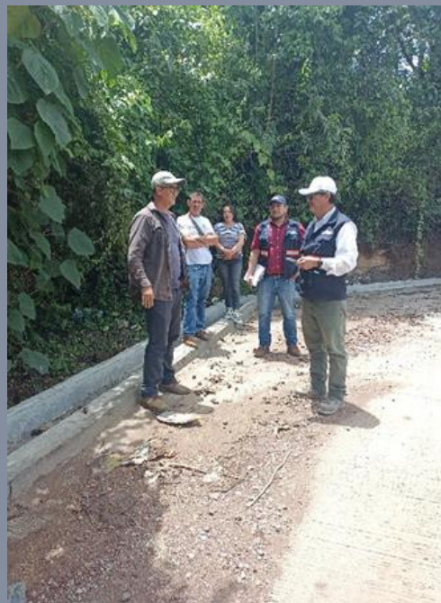
Vista de acumulación de sedimentos por las lluvias recientes lo cual ocasiona peligro para los usuarios.
