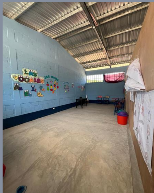
Vista interior de las aulas.
