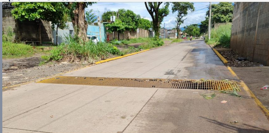
Canal con rejilla para el manejo de las aguas pluviales
