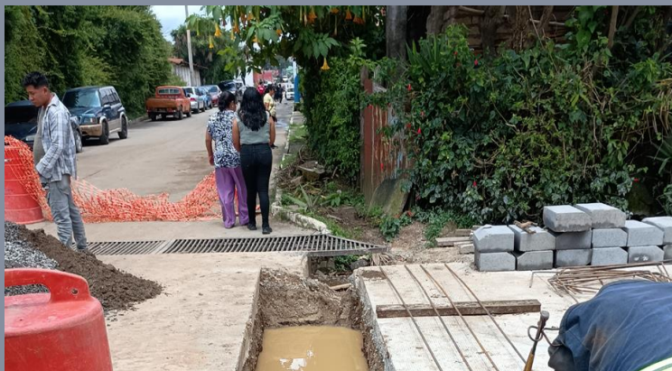
Construcción de canales con rejilla para manejo de aguas pluviales.
