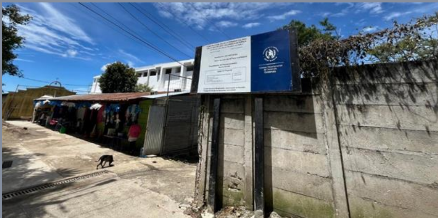
Vista aulas improvisadas y acceso al proyecto.
