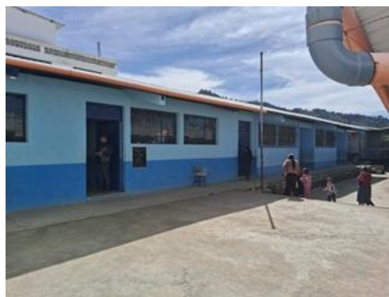
Vista de la cubierta nueva en el aula del extremo derecho.
