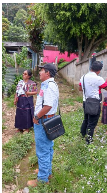
Muro perimetral escuela.
