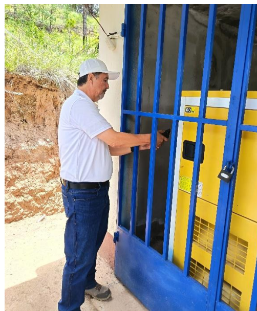
Generador del proyecto.
