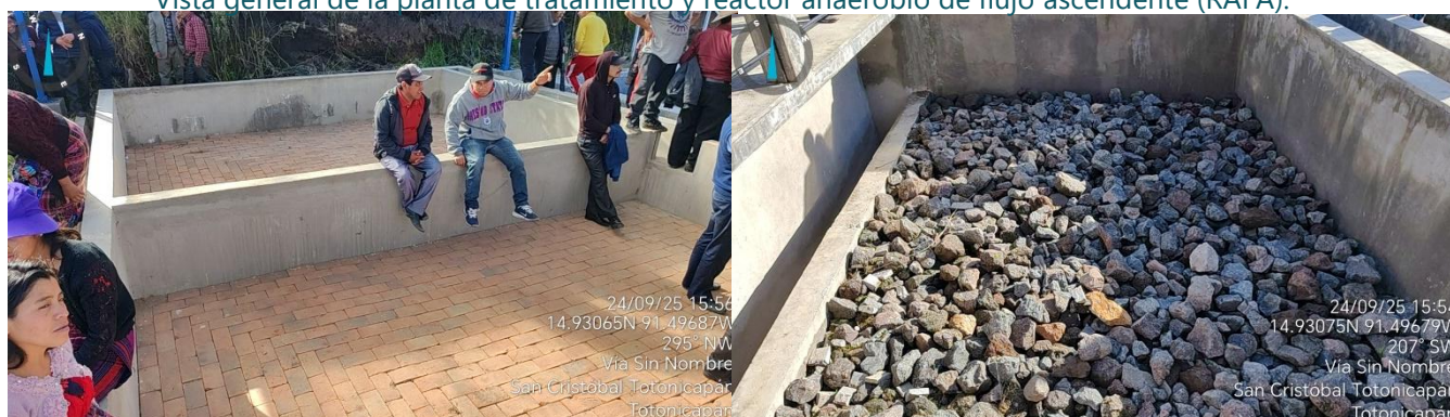
Patios de secado de lodos y lecho del filtro anaerobio de flujo ascendente (FAFA).
