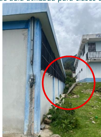
Conformacion de talud.
