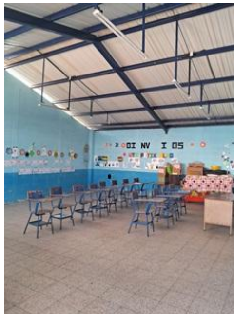
Vista interior de una de las aulas.
