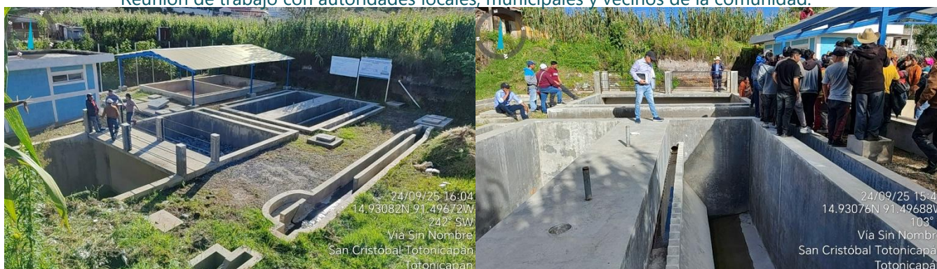
Vista general de la planta de tratamiento y reactor anaerobio de flujo ascendente (RAFA).
