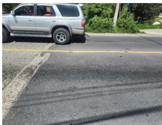
Túmulos de concreto contruidos.
