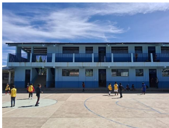
Fachada del instituto.
