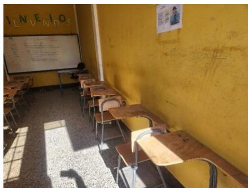
Interior de aula (es una bodega, pero funciona como aula).
