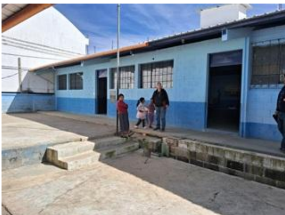
Vista de las dos aulas nuevas construidas.
