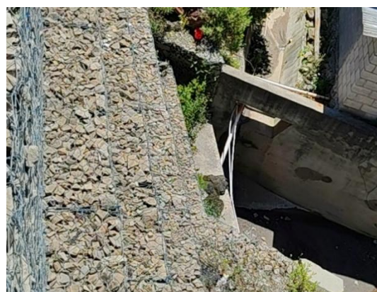
Talud de estabilización.
