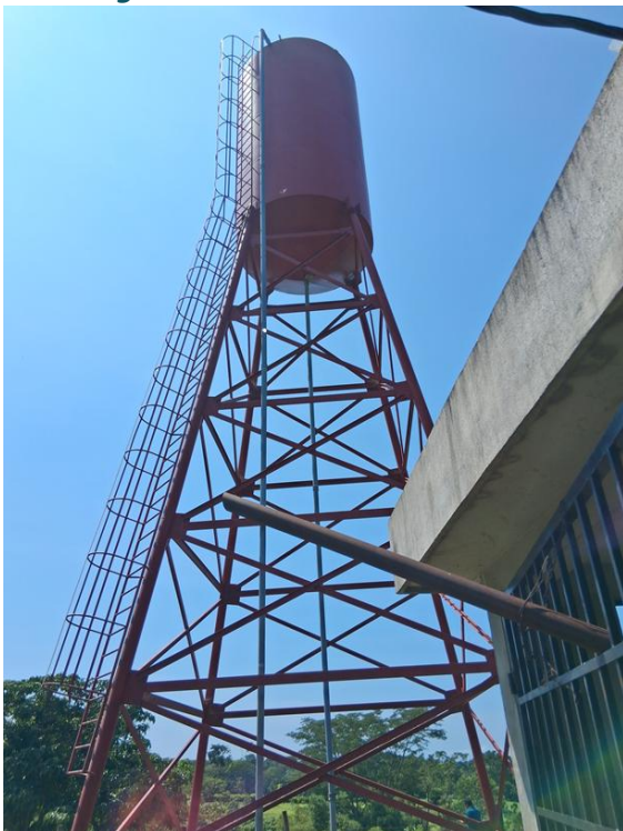
Tanque de almacenamiento de 80 m 3 . Latitud 14°40'23.60"N y Longitud 91°52'18.40"O
