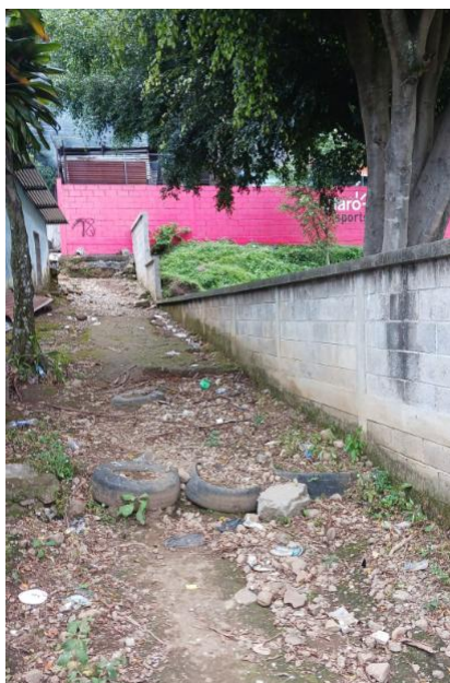
Muro perimetral lindero.
