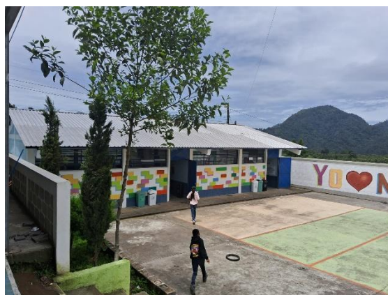
Fachada del instituto
