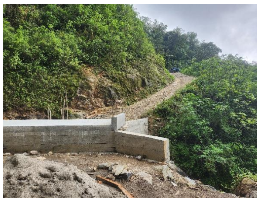
Drenaje transversal en construcción
