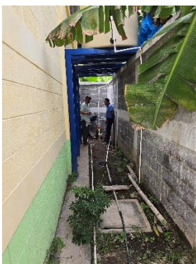
Instalación hidráulica expuesta y sin protección, infraestructura rodeada de plantación de banano
