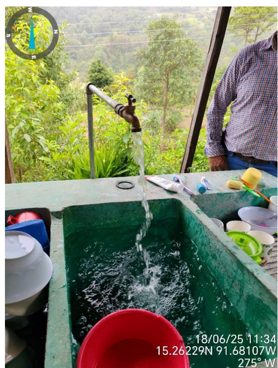
Servicio de agua en vivienda visitada.
