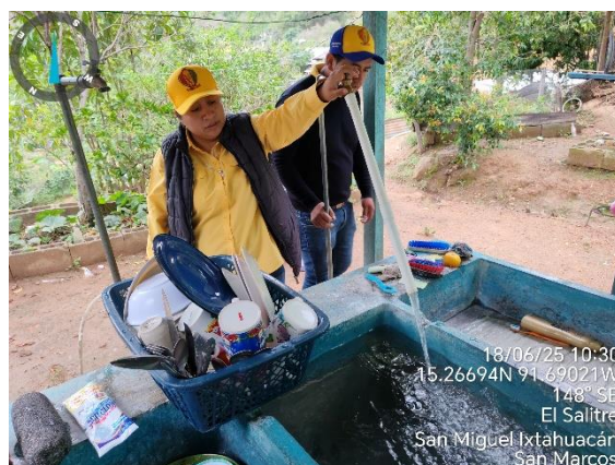
Servicio de agua en vivienda visitada.
