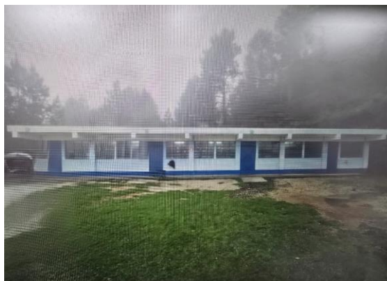
Ingreso a las instalaciones educativas, se observa encharcamiento de agua de lluvia
