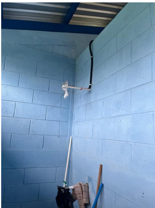
Duchas inhabilitadas y convertidas en chorros
