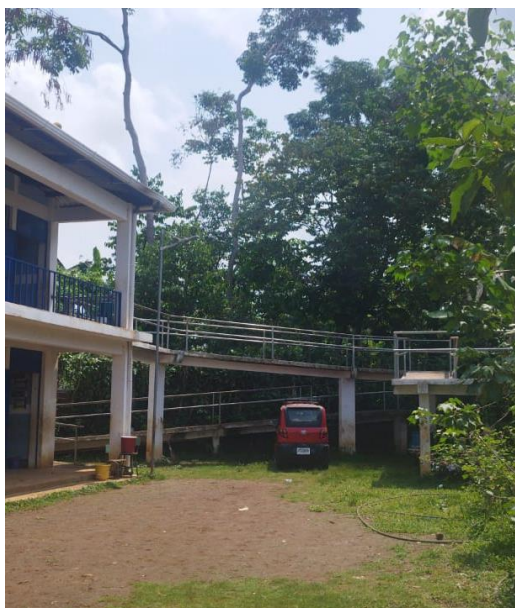
Rampa en escuela.
