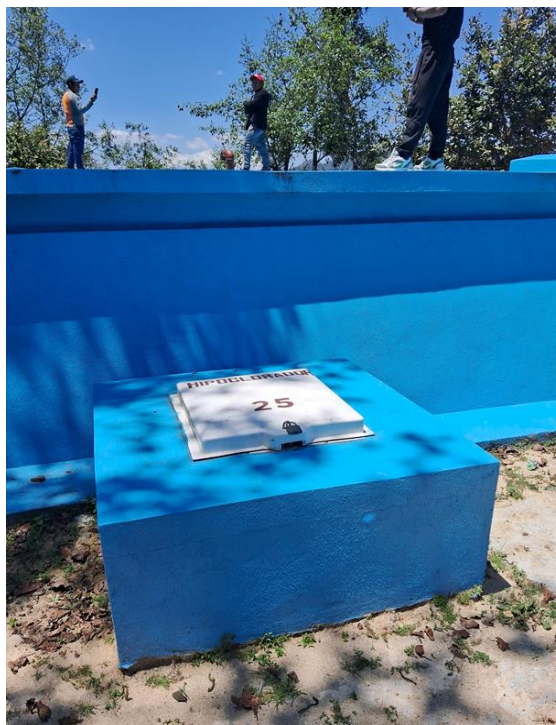
Tanque de distribución y caja del sistema de desinfección del agua.
