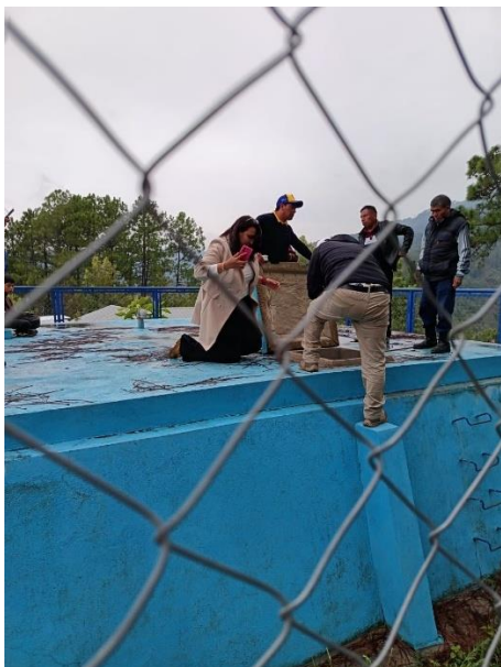
Verificación del tanque de almacenamiento.
