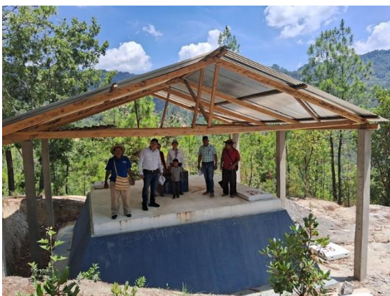
Tanque de distribución de 25 metros cúbicos.
