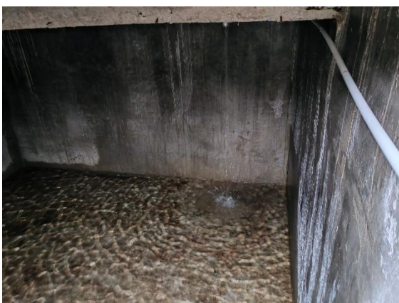
Vista del caudal del tanque.
