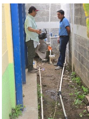
Instalación hidráulica expuesta y sin protección, infraestructura rodeada de plantación de banano
