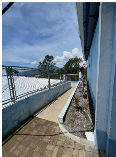
Rampa acceso módulo 2
