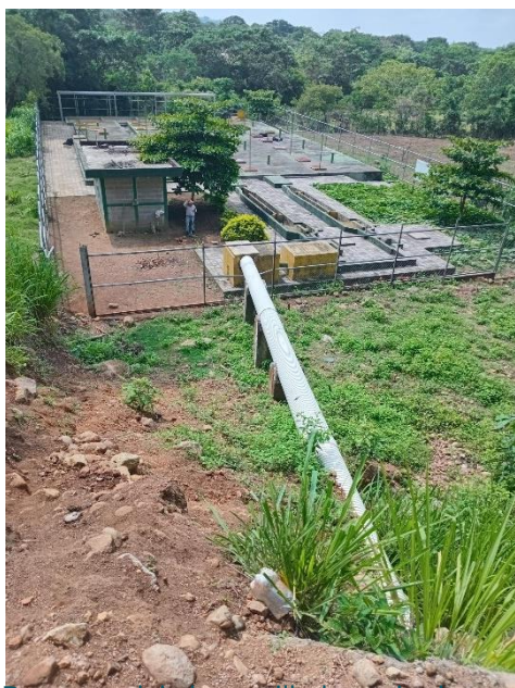
Descarga del alcantarillado sanitario
