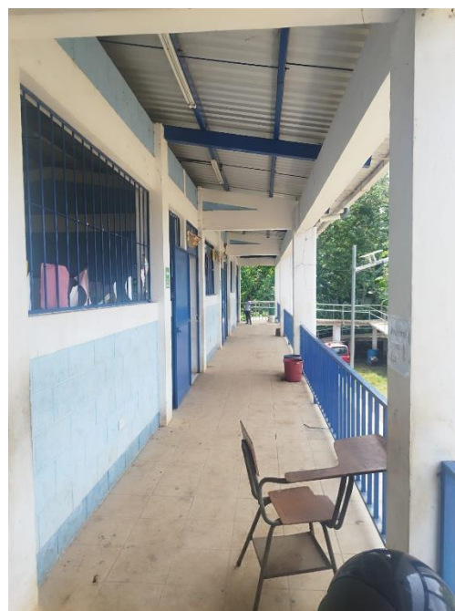
Pasillo segundo nivel.
