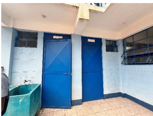
Área de baños
