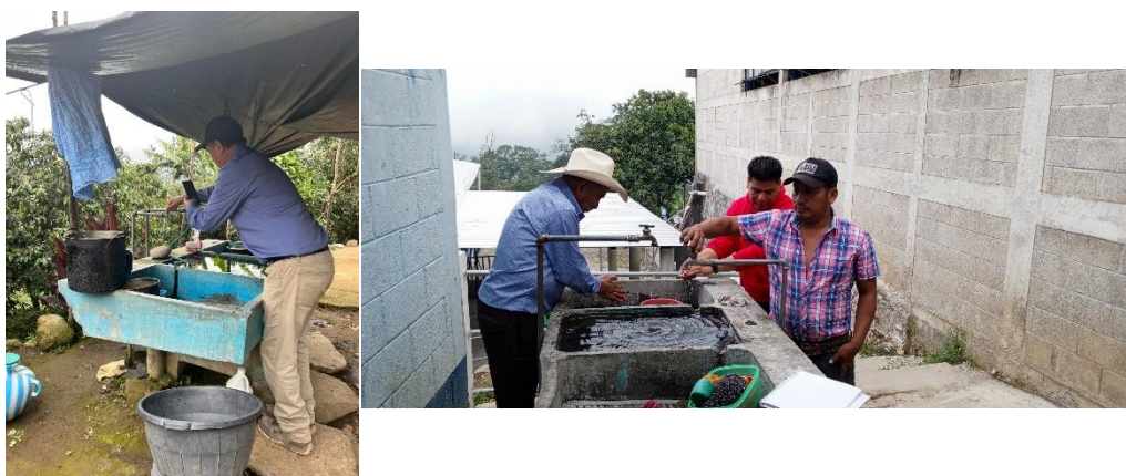
Revisión de conexiones prediales del proyecto sin agua, beneficiarios tiene agua otro sistema existente. Fuente: Dirección de Análisis y Seguimiento de la Inversión con base en visitas de campo, 22 abril de 2025.
