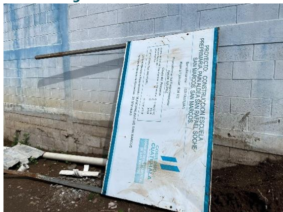
Rótulo informativo de la ejecución (por inclemencias del clima este se encontró tirado en el área del proyecto)
