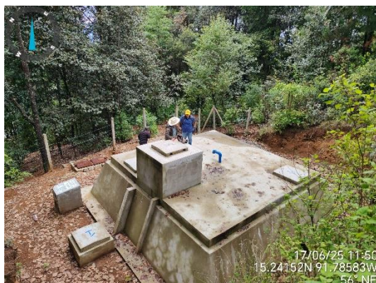
Tanque de distribución y aforo de caudal de ingreso al tanque
