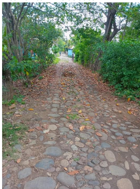
Tramo de alcantarillado con hundimiento
