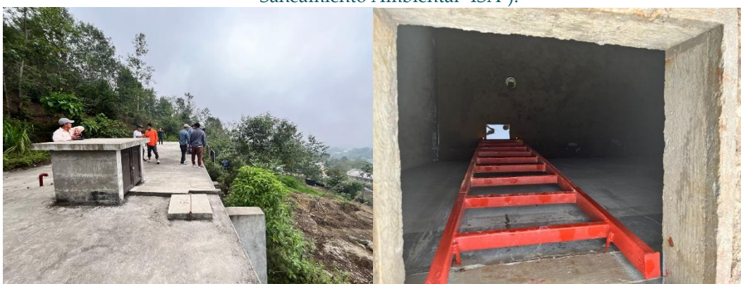
Tanque de distribución vacío y caja de hipoclorador.
