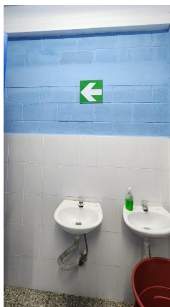
Área de sanitarios
