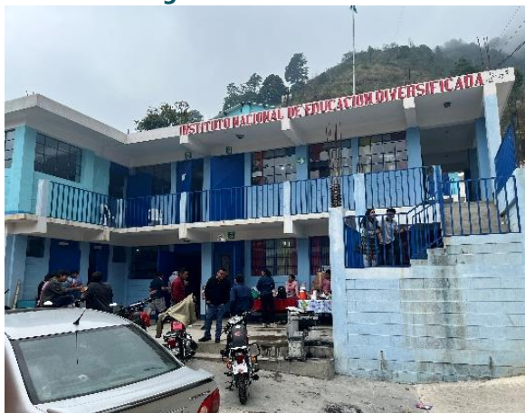
Fachada del instituto (sin rótulo informativo de la ejecución)
