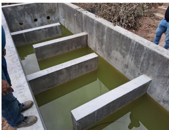
Vista del tanque de contacto.
