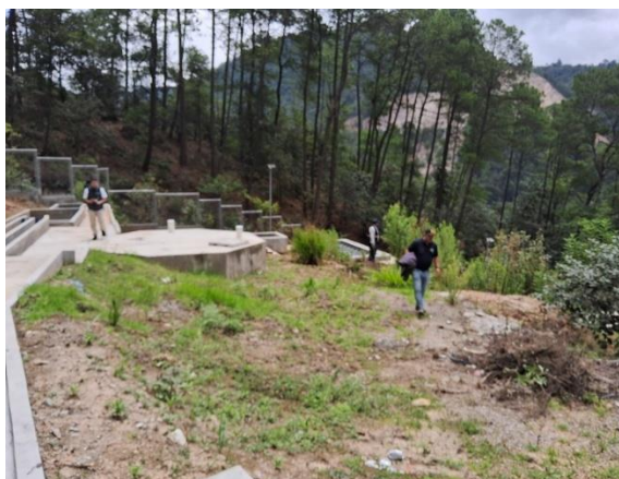
Panorámica de la PTAR.
