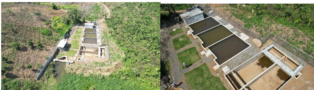
Vista general de planta de tratamiento de agua potable, filtración lenta
