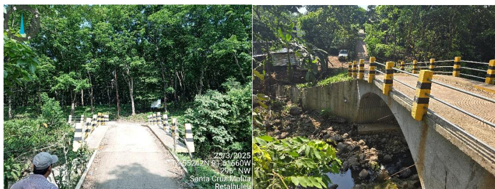
Construcción puente tipo bóveda de un carril
