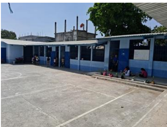
Vista del centro escolar
