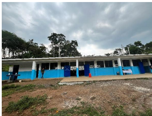
Fachada del instituto
