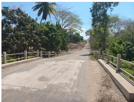
Vista superior del puente vehicular
