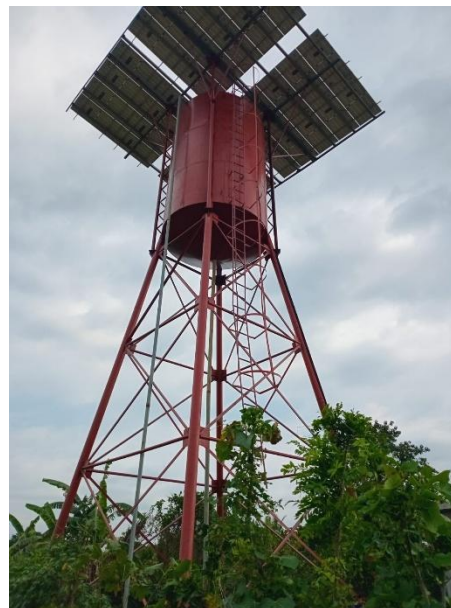
Vista de tanque elevado.
