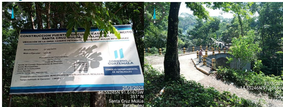
Rótulo del proyecto y construcción puente tipo bóveda
