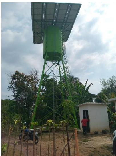
Vista del tanque elevado y caseta del proyecto
