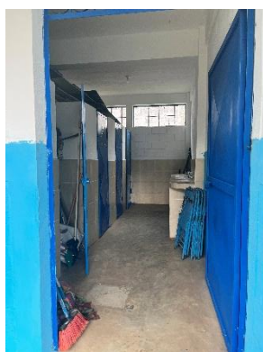
Área de sanitarios
