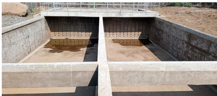
Desarenador vacío
