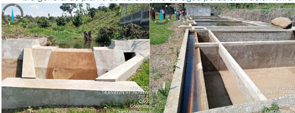
Captación agua superficial y desarenador vacío
