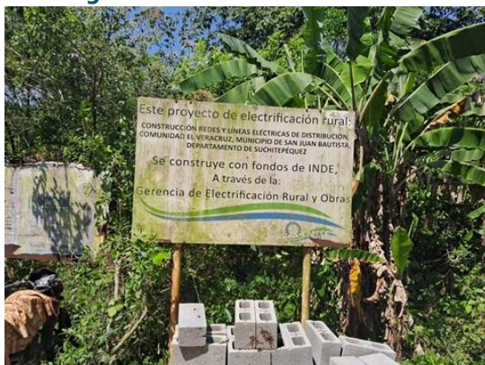
Rótulo de ejecución del proyecto
