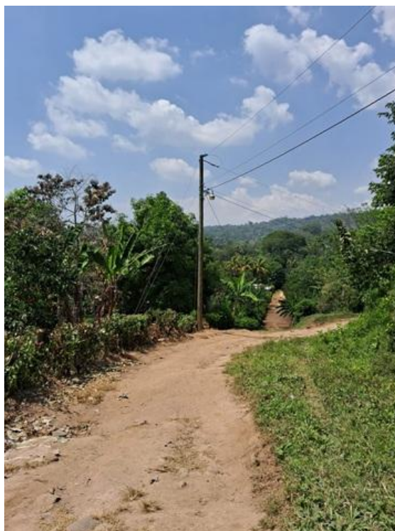
Poste en la línea de distribución de media y baja tensión.
