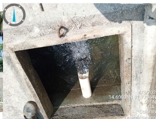
Tanque de distribución e ingreso caudal a tanque el caudal es menor al de diseño
