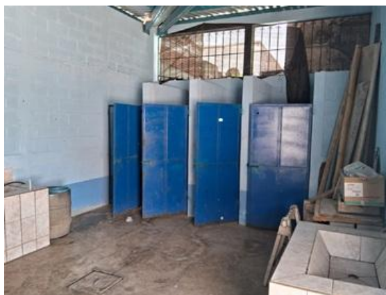
Vista de los servicios sanitarios mejorados.
