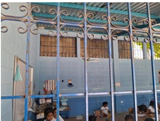
Vista de un aula y muro alledaño construido.
