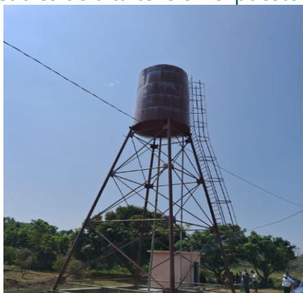
Vista completa del depósito de agua
